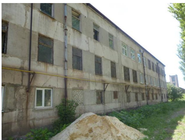
Рис. 1. Вигляд будівлі лабораторно-побутового корпусу.
